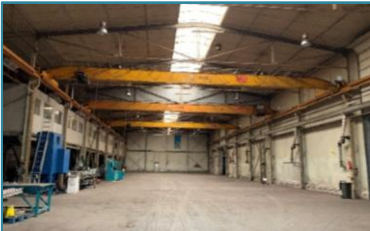
Rysunek 6 – budynek nr 2 (widok wewnątrz)
