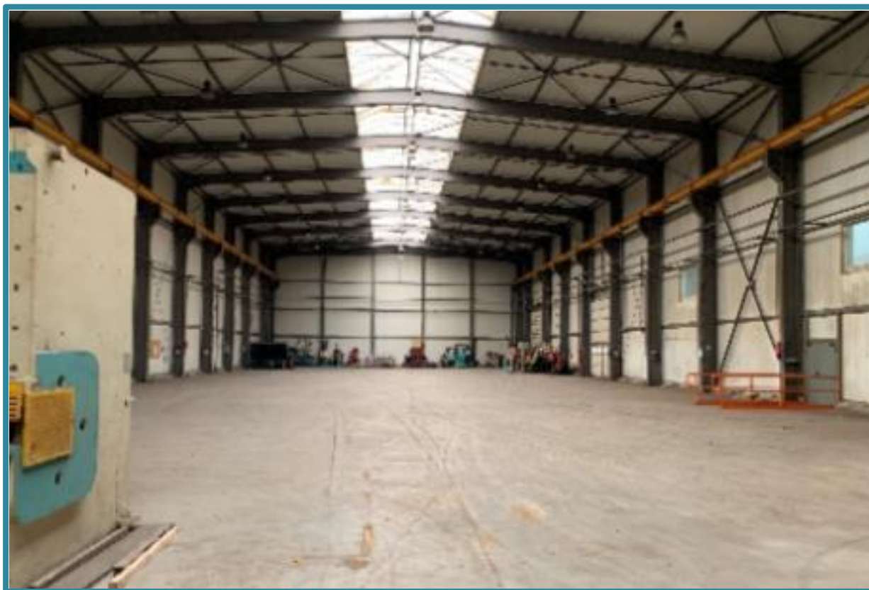
Rysunek 10 – budynek nr 3 (widok wewnątrz)
