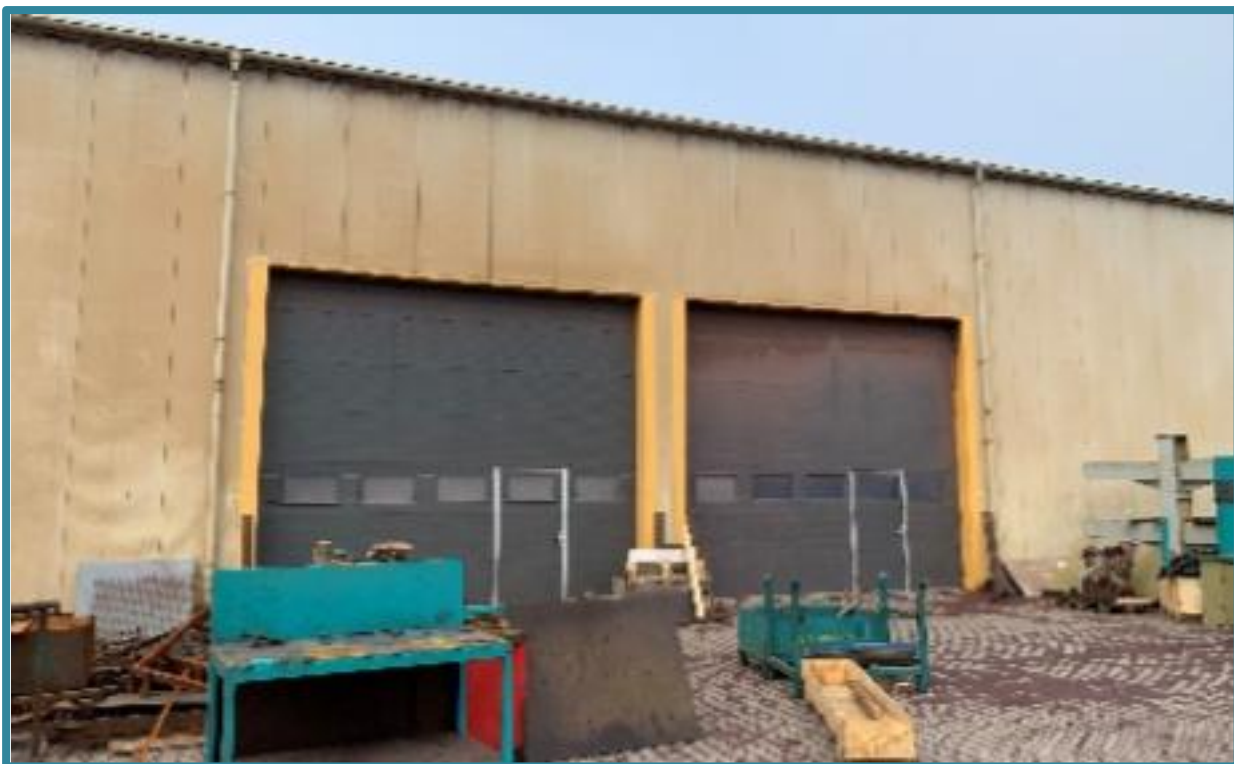
Rysunek 7 – budynek nr 2a (widok z zewnątrz)
